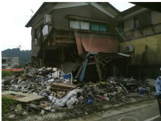
■支流と合流する箇所の被害が深刻、家の二階部分まで浸水
