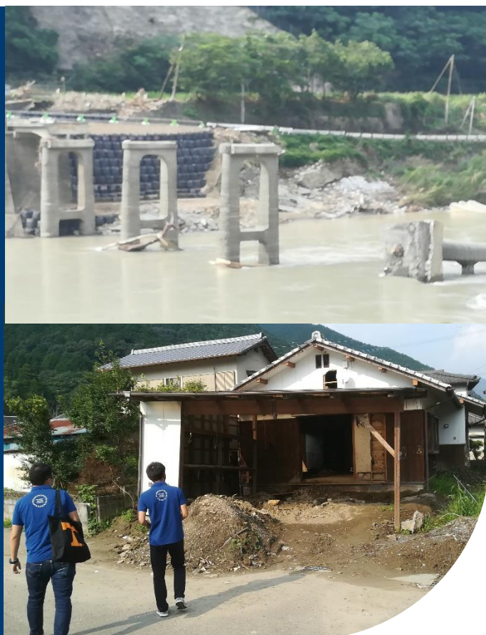
上) 熊本県球磨川氾濫による橋の流失 下) 浸水被害を受けた球磨村の住宅
